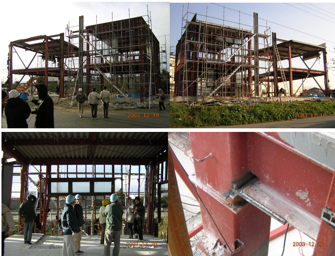
写真 実在鉄骨造事務所建築の加力実験風景（鉄連九州地区サブネットワークと共催）
