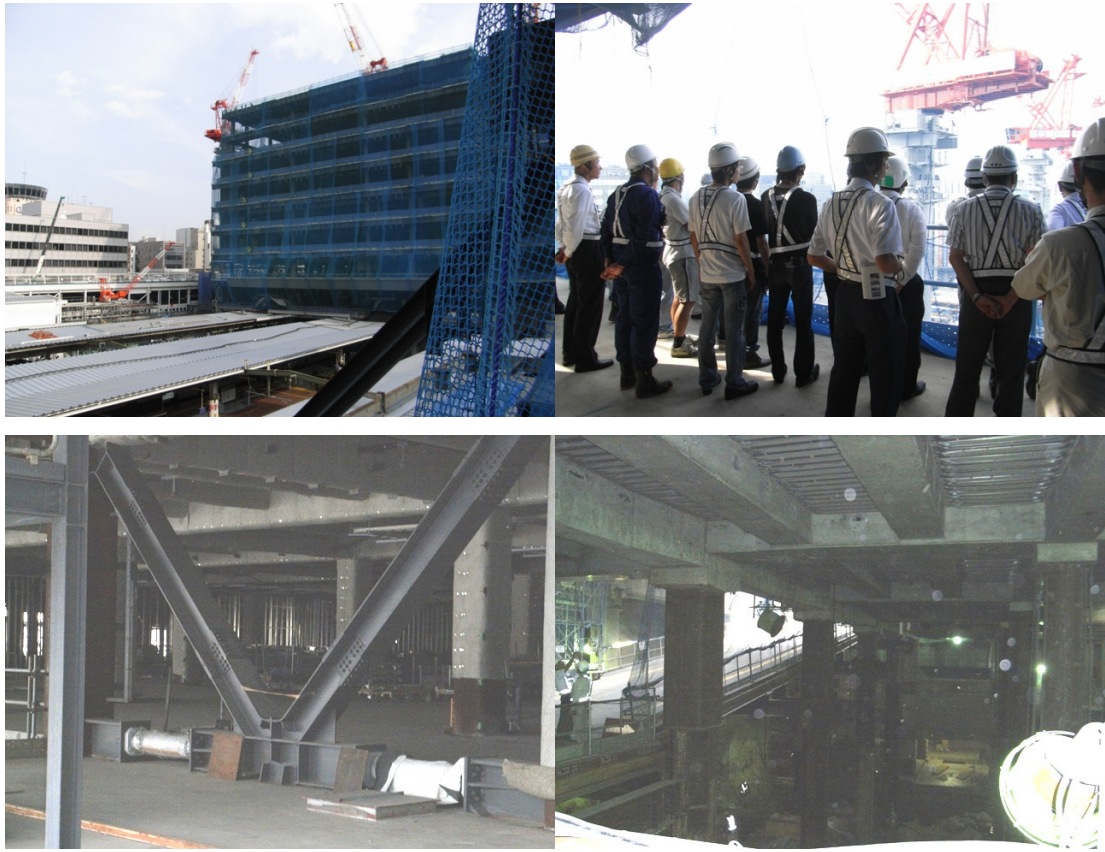
写真 博多駅ビル建設現場見学会
